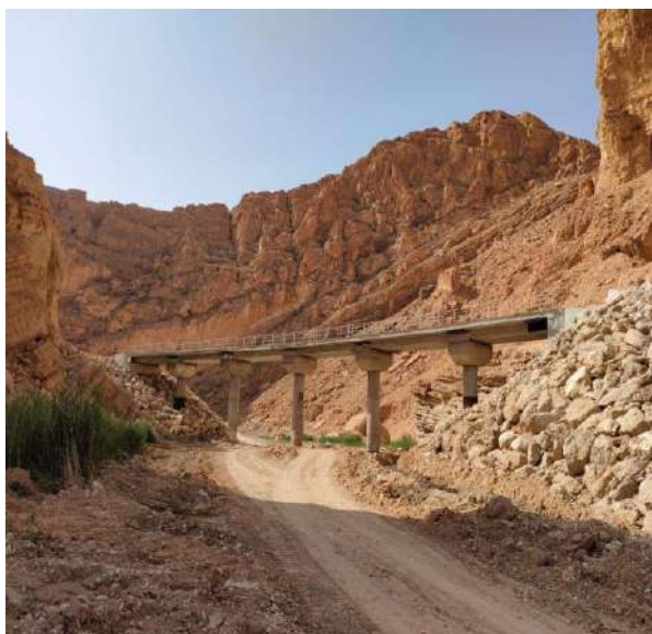
Après achèvement des travaux
