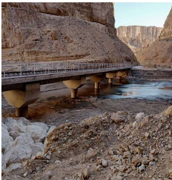
Après achèvement des travaux
