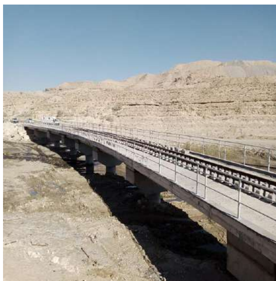
Après achèvement des travaux
